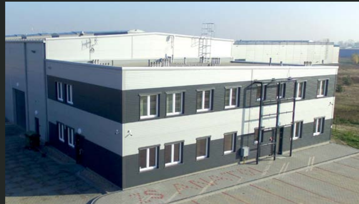
Budowa hali produkcyjnej i malarni proszkowej dla firmy ANATOL, kubatura 14897,52m 3 , powierzchnia zabudowy 2041,06m 2 .
