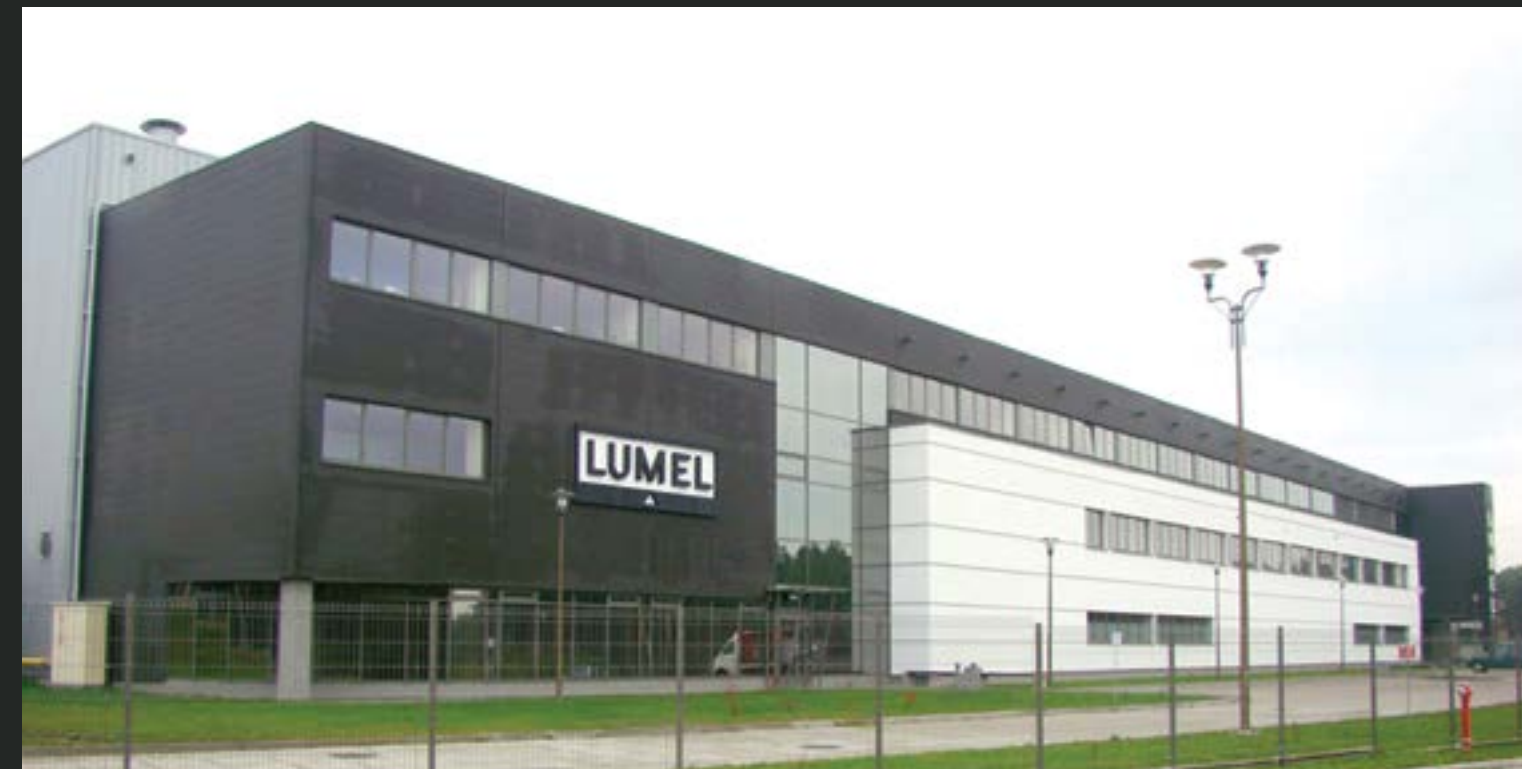
Dla firmy Lumel z Zielonej Góry zrealizowaliśmy projekt budynku socjalno administracyjnego.
