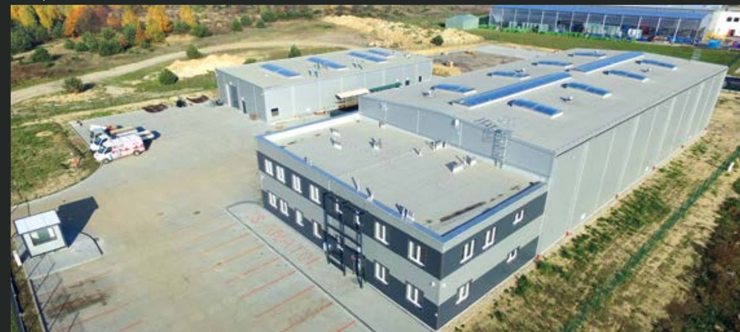
Der Bau einer Produktionshalle und eines Pulverbeschichtungswerkstattes für die Firma ANATOL, Kubatur des Gebäudes von 14897,52m 3 und Grundfläche von 2041,06m 2 .
