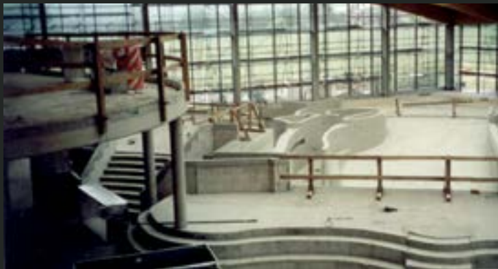
Aquapark „AquaMagis“ Deutschland, Sportschwimmbad, Soleschwimmbad, künstlicher Fluss, Jacuzzi, Planschbecken und Wasserattraktionen für Kinder. Das Schwimmbad draußen. Saunen.
